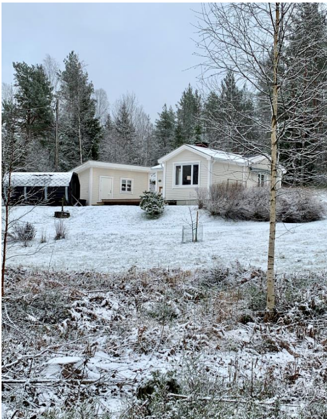
Bild 58. Huset på den avstyckade tomten Stavsjö 2:47 har byggts om och byggts till
